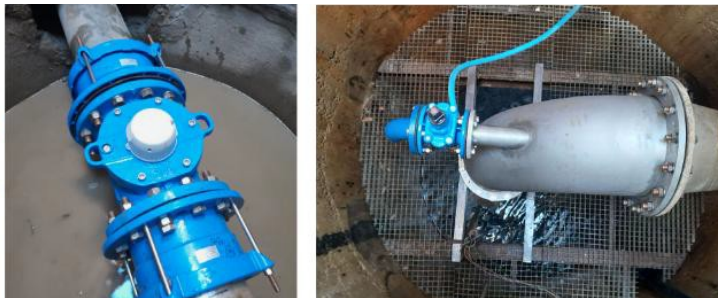
Travaux sur un puits de Comps
